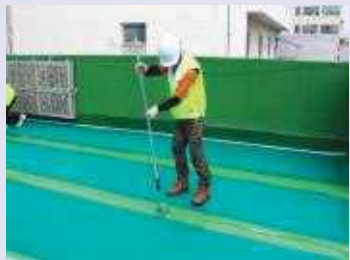
③ 접합부 시공 (보강섬유 및 우레탄 시공)
