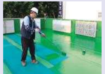
④ 난연성 탑코트 시공
