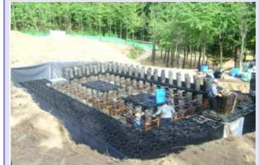
<통로부 조립 시공 사진>
