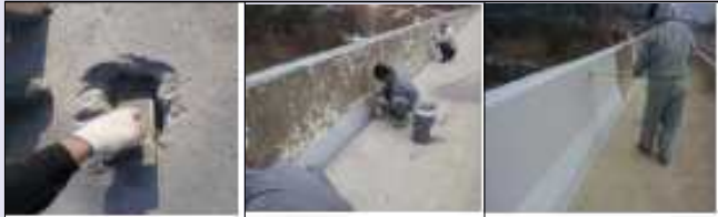
4.방청 단면복구재 시공 5.방청 표면피복재 시공 6.마감 도장
