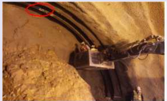
《(그림3)신기술의 강지보재 설치》
