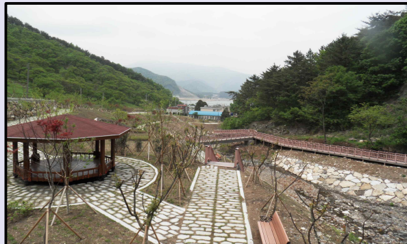
〈양산시 원동소하천 정비 전경〉
