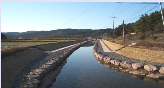
〈창녕 소하천(세진천) 정비 전경〉
