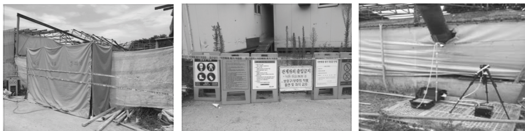
〈그림 3-1-8〉 슬레이트지붕 철거 및 비산먼지 측정
